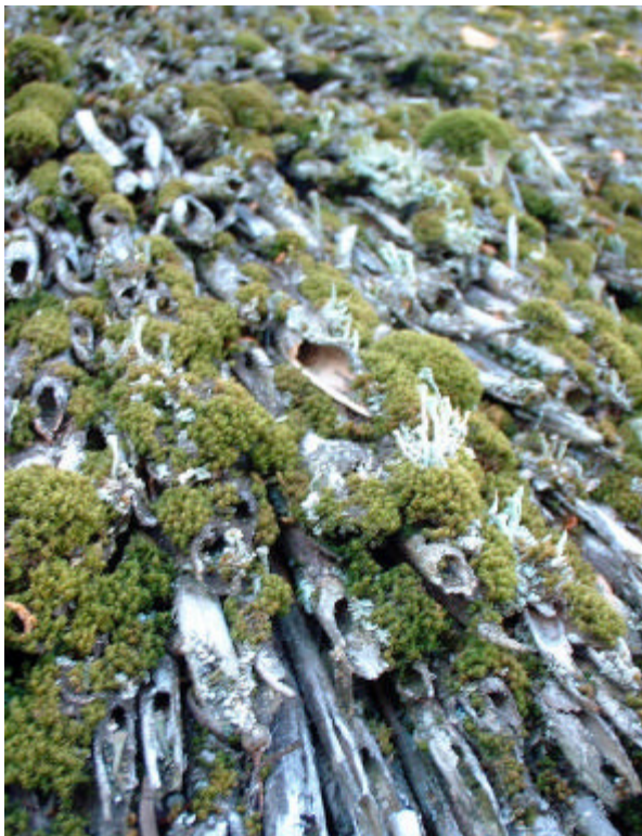
Foto nr. 32: mosdannelse på et 35 år gammelt tagrørstag i Bordesholm 2003.
