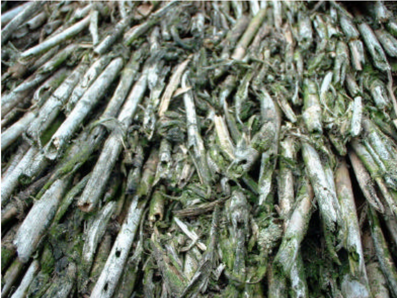
Foto nr. 33: forvitningsgraden på et 16 år gammelt miscanthustag i Jylland, Norddanmark.
