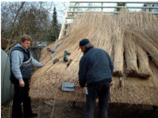
Foto 2: Formning af tagfladen ved hjælp af klapning med tækkeskovlen.
