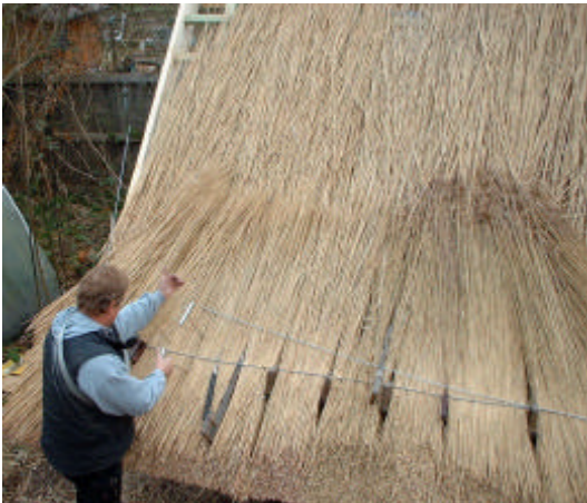
Foto 1: Syning af taget; til venstre miscanthus, til højre tagrør.
