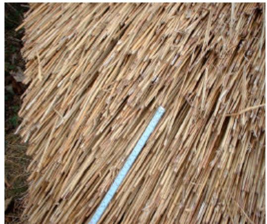
Foto 5: Længden af de synlige miscanthusrør ved gavlafslutning.
