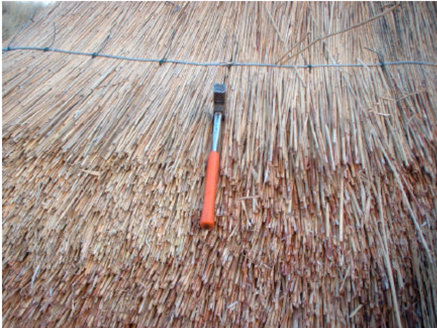
Foto: 14 Farve- og strukturforskelle mellem tagrør (venstre) og miscanthus (højre) på beklædningstidspunktet.
