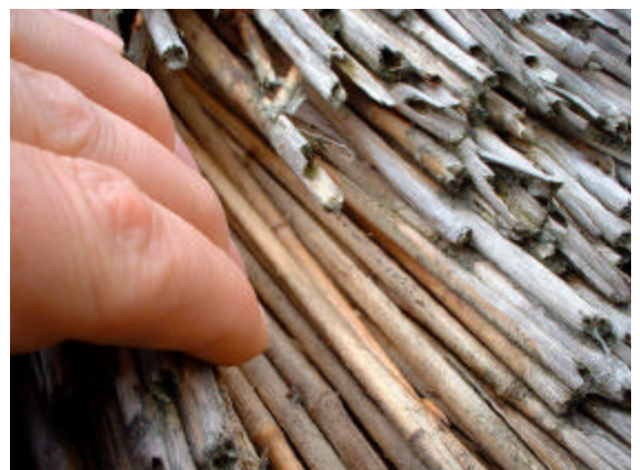
Foto 12: Ingen forvitring på grund af fugtighed i miscanthusmaterialet.
