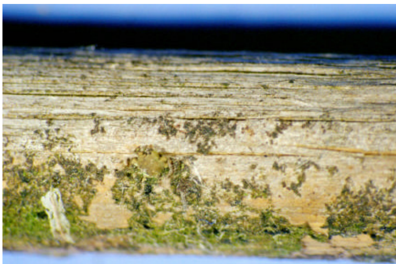
Foto nr. 27: Påvirkning fra solens UV-stråling på miscanthus 18 måneder efter færdiggørelse af taget i Albersdorf (set fra siden).
