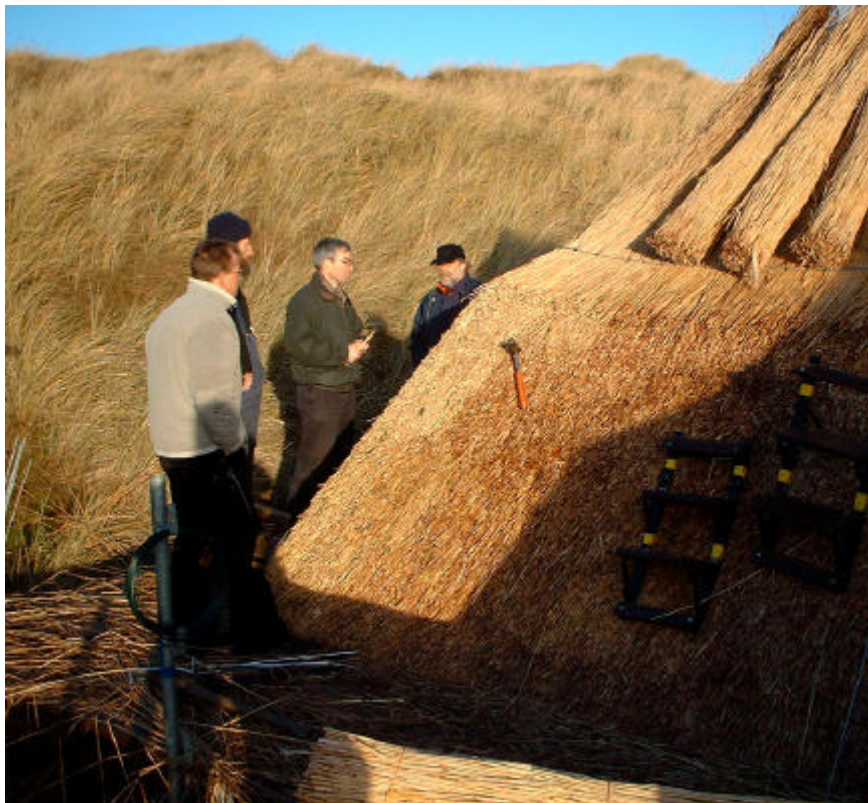
Foto: 13 Referencetaget under byggearbejdet den 18.01.02. Tydelige farveforskelle på tagrør (lyse, ved grat) og miscanthus (rødlige, nenedunder, til højre for grat).
