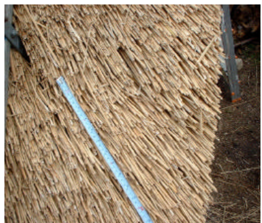
Foto 6: Længden af de synlige tagrør ved gavlafslutning.
