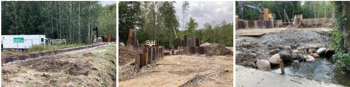
Ny konstruktion med spunsvægge i selve jordvolden og siden af åen. Foto Frank Bondgaard. SEGES Innovation 2024.
