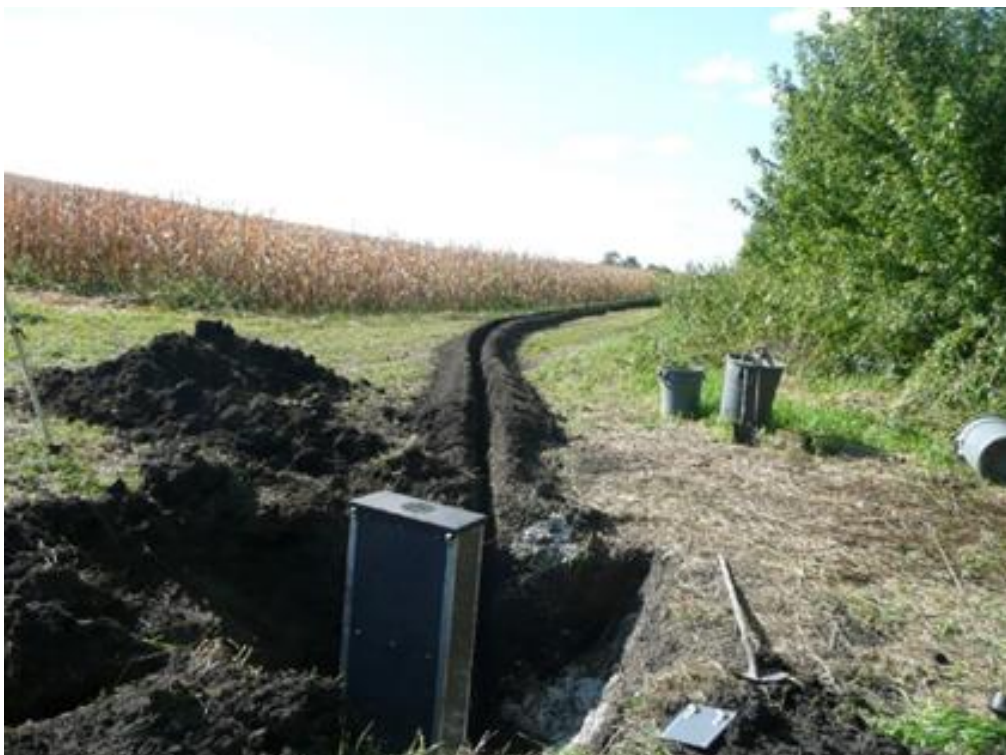
Etablering af reguleringsbrønd i en mættet randzone i Iowa. De amerikanske landmænd anvender nogle steder kun miljøtiltaget i vinterhalvåret, andre steder hele året. Foto Dan Jaynes USDA
