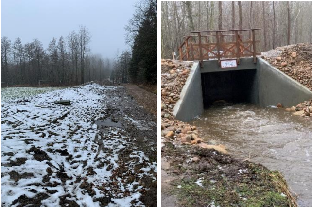
Tidligere konstruktion af klimatiltag med jernplade med et mindre hul og jordvold. Foto Frank Bondgaard. SEGES Innovation 2023.
