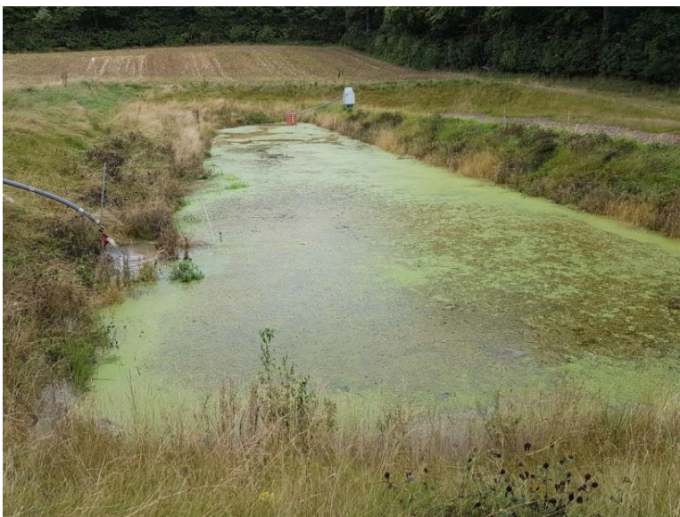
Figur 6. Foto af stuvningsbassin før filtermatrice. Foto viser frit drænindløb til stuvningsbassin (forrest tv), og bagerst det vertikalt opslidsede stuvningsrør med en horisontal rørføring til fordelerrøret (bagerst th). Stuvningsbassinet ses her ved høj vandstand. Foto: Charlotte Kjærgaard.
