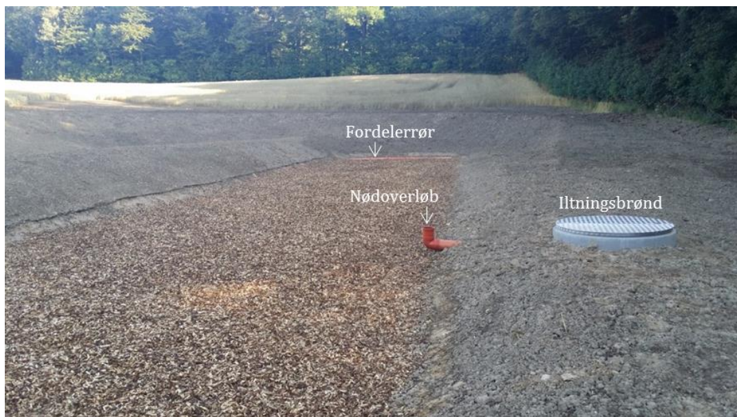
Figur 10. Foto af filtermatrice før udlægning af den umættede flis-zone. Fordelerrøret ses beliggende på toppen af flisen bagerst. Forrest ses en vinklet nødoverfløbsrør (ikke perforeret) der i tilfælde af behov for nødoverløb leder vandet direkte til iltningsbrønden. Foto: Charlotte Kjærgaard.
