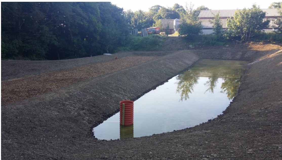
Figur 5. Foto af nyetableret stuvningsbassin til en filtermatrice. Foto viser stuvningsbassinet ved lav vandstand med horisontal rørføring til filtermatricen (yderst tv). Foto: Charlotte Kjærgaard.
