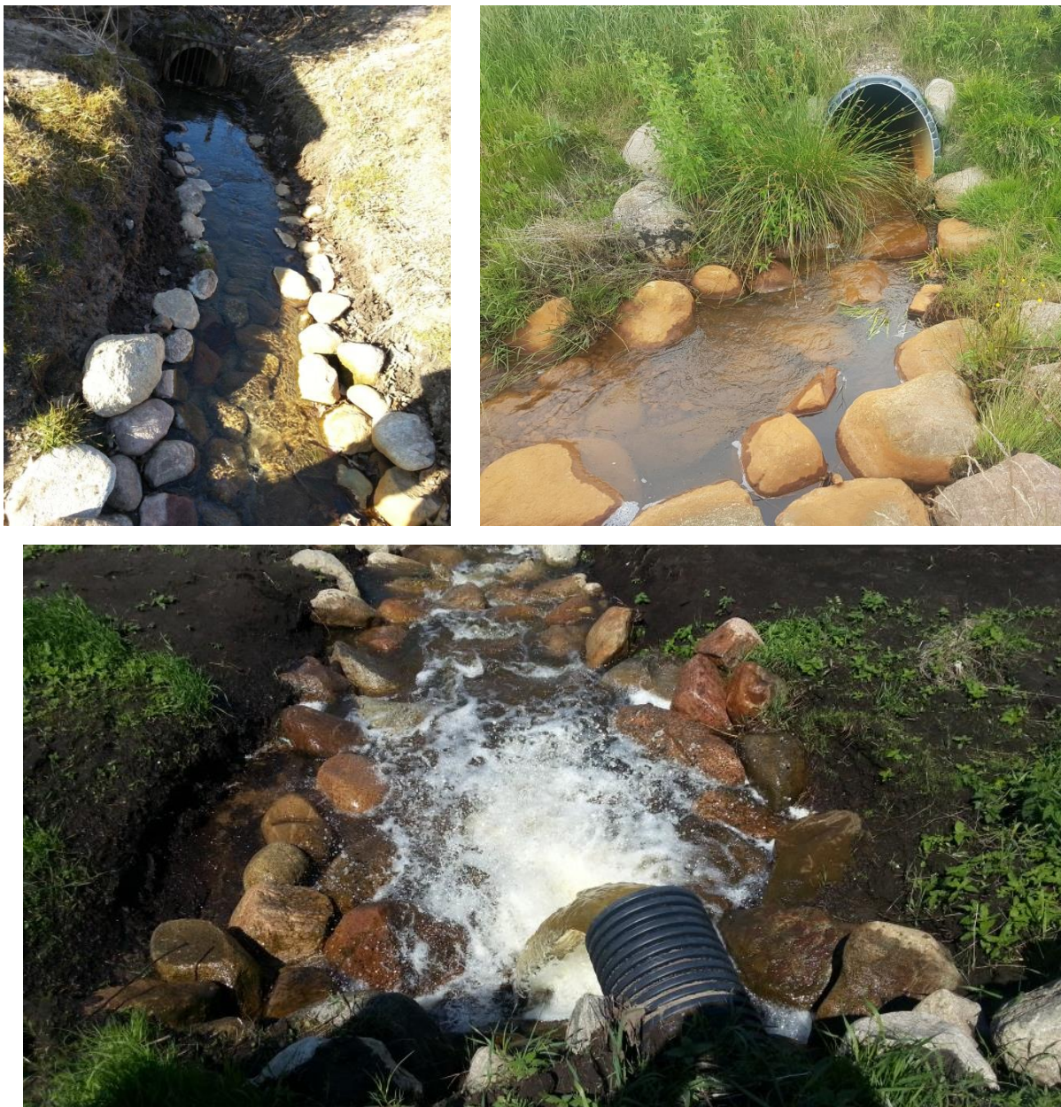
Figur 15. Eksempler på iltningstrapper/kanaler bestående af stenudlæg fra danske minivådområder. Foto viser iltningskanal med meget begrænset hældning (foto øverst tv) eller iltningstrappe med stor faldhøjde på 1 m (foto nederst). I tilfælde med jernholdigt drænvand vil iltningen bidrage til udfældning af okker (orangebelægninger på sten på foto øverst th). Fotos Charlotte Kjærgaard
