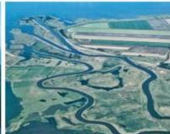
I 2003 var 19 kilometer kanal i den nederste del af åen lagt tilbage til 26 kilometer snoet vandløb.
