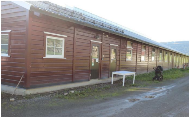
Figur 8: Norsk kostald med massiv bjælkekonstruktion (9 cm) med vægventiler og uden isolering. Udvendig behandlet med oliebaseret træbeskyttelse.
