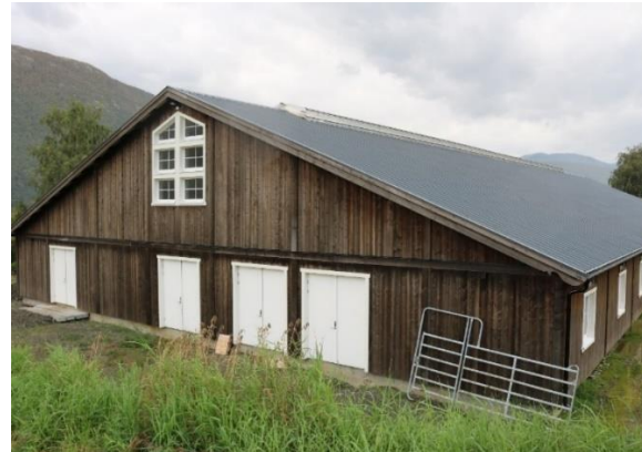
Figur 9: Norsk kostald med indvendige vægge af krydslamineret træ og udvendig træbeklædning behandlet med jernvitriol.
