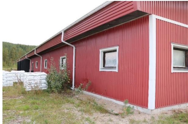
Figur 13: Svensk grisestald fra 2006 med udvendig beklædning i stålplader.
