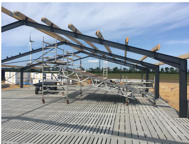
Figur 1: Stålspær som bærende konstruktion i en stald.
