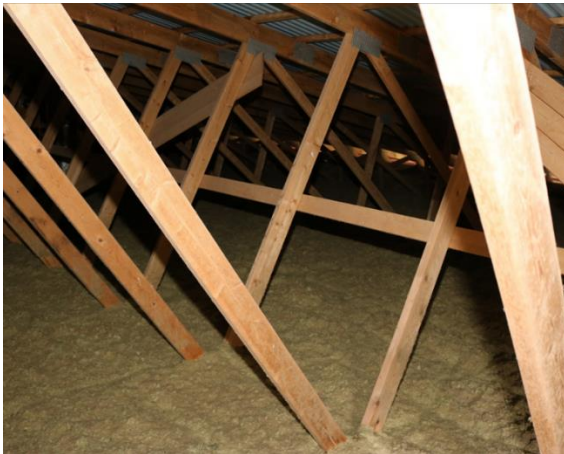
Figur 12: Svensk grisestald fra 2006 med tagkonstruktion i gitterspær.
