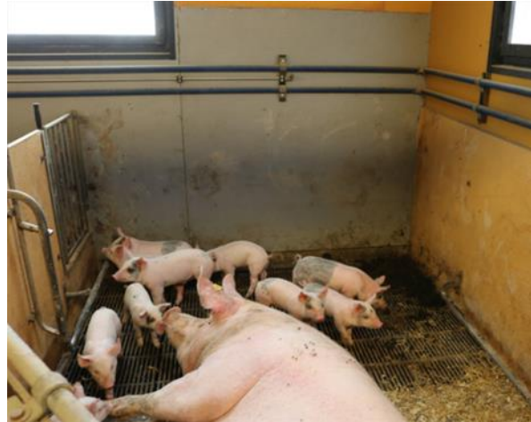
Figur 15: Ydervægsbeskyttelse med cementbundne spånplader og inventar af fiberbeton.
