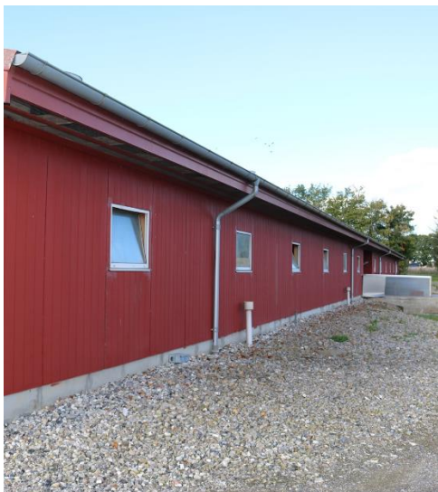
Figur 18: 25 år gammel Ø-stald beklædt med de oprindelige træplader og en sokkelhøjde på 20 cm samt tagrender og nedløbsrør, der har kunnet hindre, at underkanten af vægbeklædningen blev fugtig.
