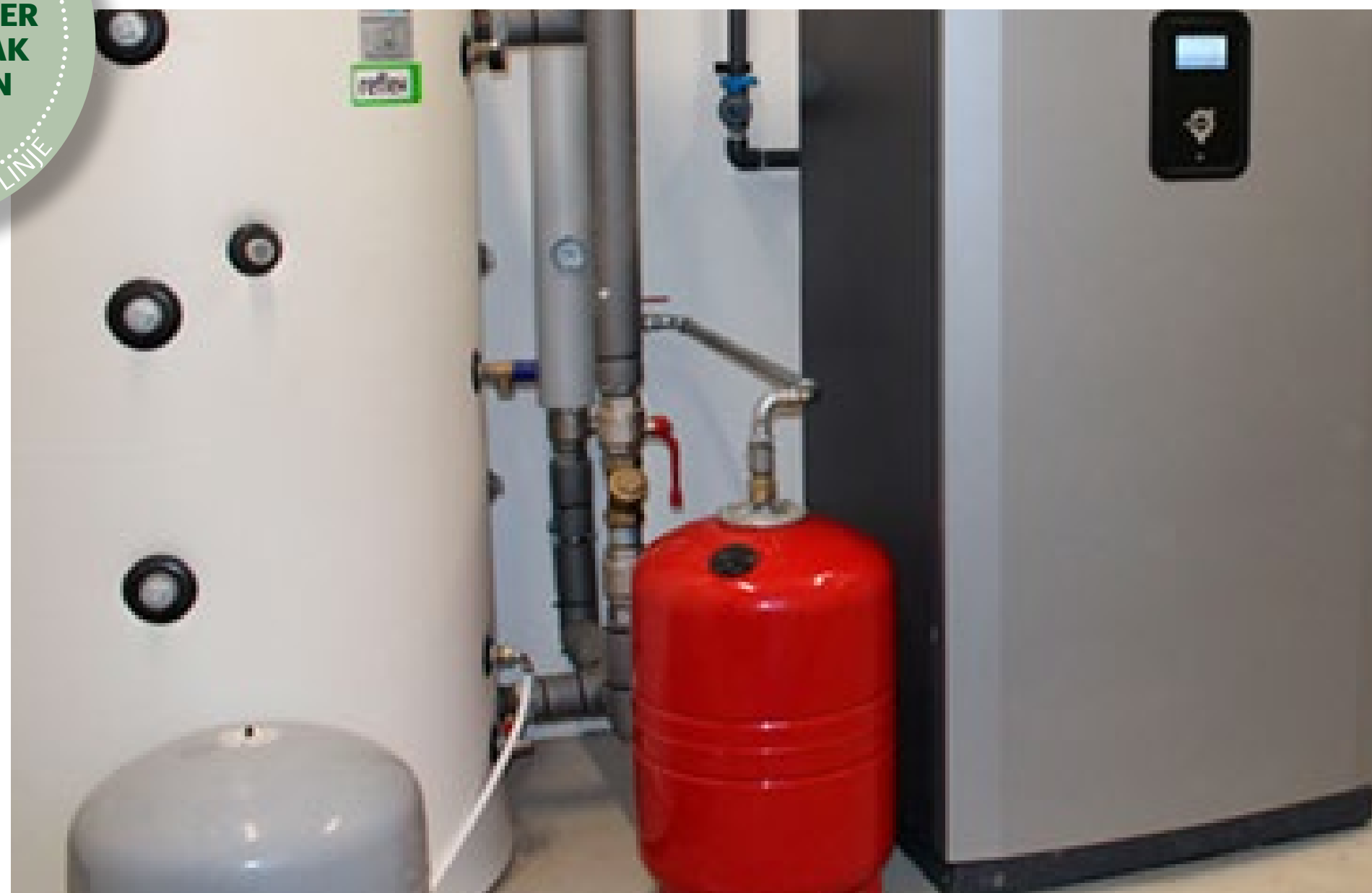
Styringen, samt udlægning af slanger lige inden de overstøbes med cement ved byggeri. Foto: SEGES Innovation
