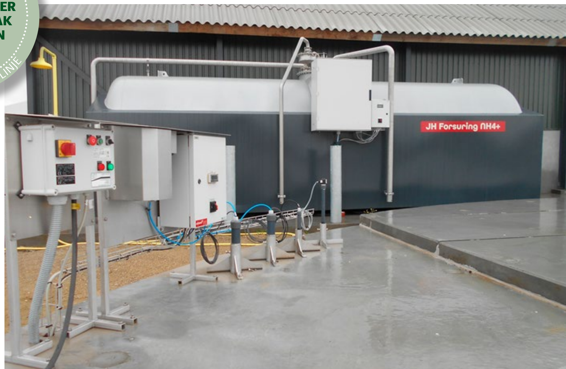
Procestanken hvori syren tilsættes gylle fra stald. Foto: SEGES Innovation
